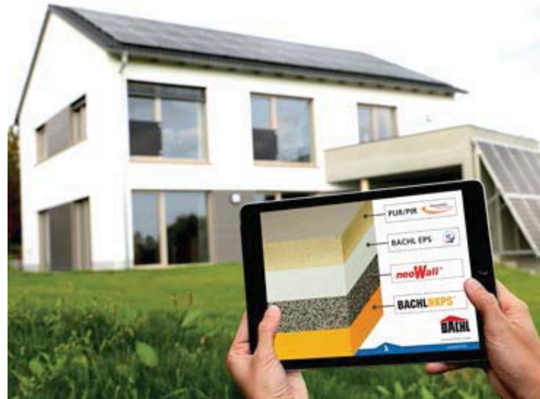
Die verbauten Dämmstoffe im neu errichteten Energieeffizienzhaus Plus der Firma Bachl tragen dazu bei, dass das Haus mehr Energie erzeugt, als es verbraucht.
