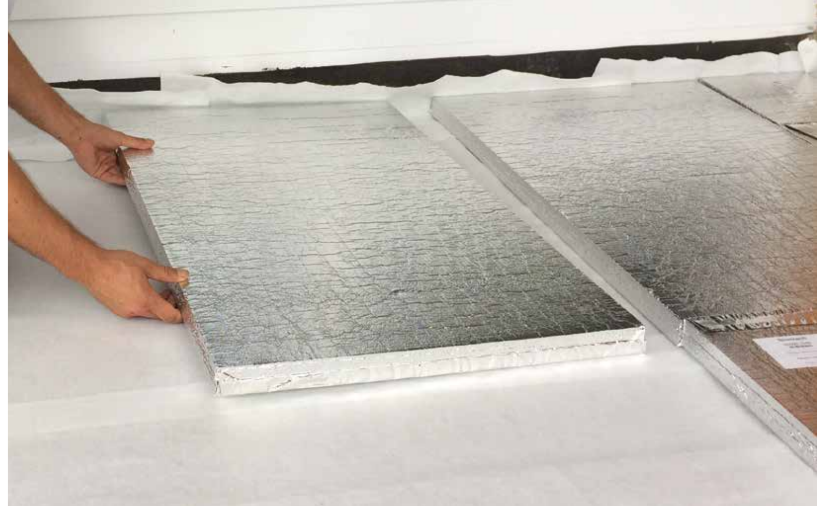
Verlegung von Vacuboard für Balkonaufbau.
