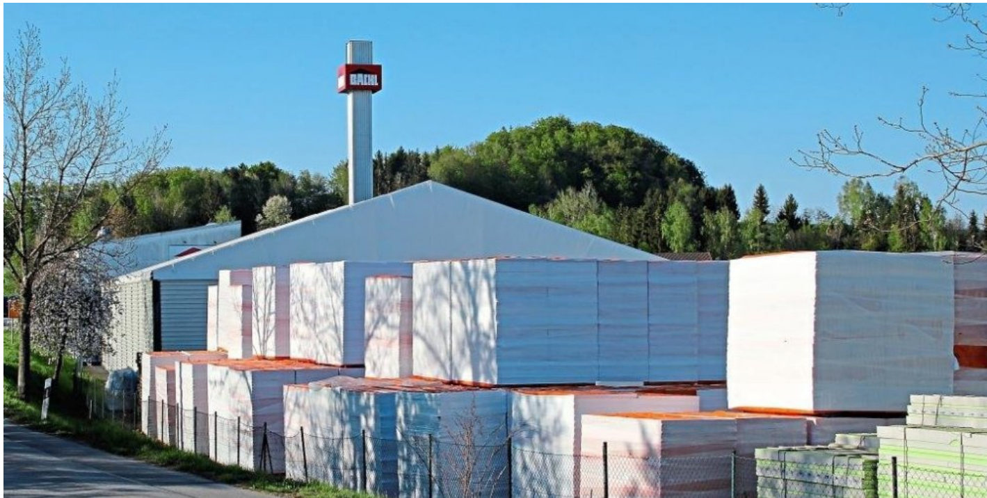
Auf wenig Gegenliebe stößt die Kunststoff-Dämmplatten-Produktion der Firma Bachl in Tittling-Hörmannsdorf. Ihr Antrag auf Errichtung einer zweiten Fertigungslinie ist jetzt über den Marktgemeinderat hinweg vom Landratsamt Passau bewilligt worden. –Foto: Brunner
