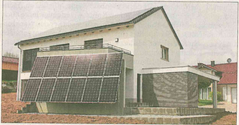
Von außen auffallend an dem Energieeffizienzhaus Plus: die Photovoltaikanlage neben der Terrasse des Musterhauses am Hafnerfeld in Loizersdorf.
